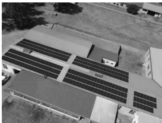
Slika 4. Realizivana FN elektrana snage 100kW
